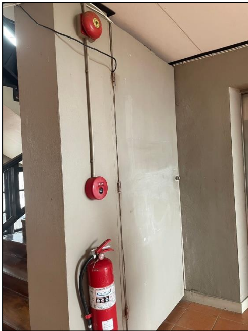
Alarm Bell, Manual Alarm และถังดับเพลิงแบบมือถือ
